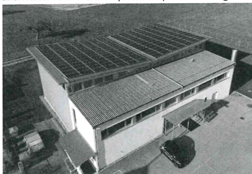
Bild: PV-Anlage Brünisried
